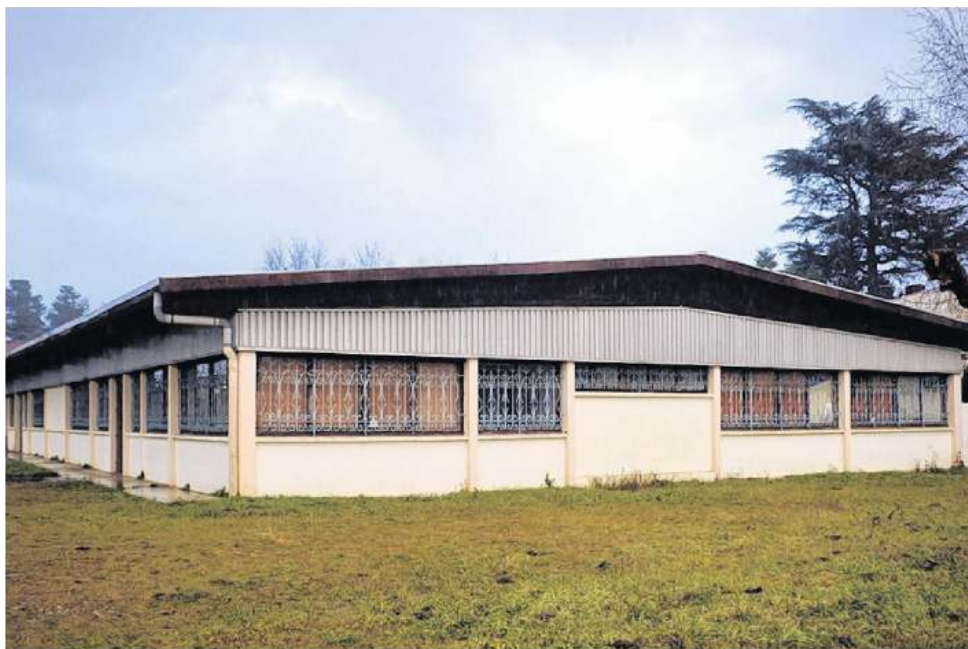
La réhabilitation du bâtiment acheté en 2014 va commencer.
